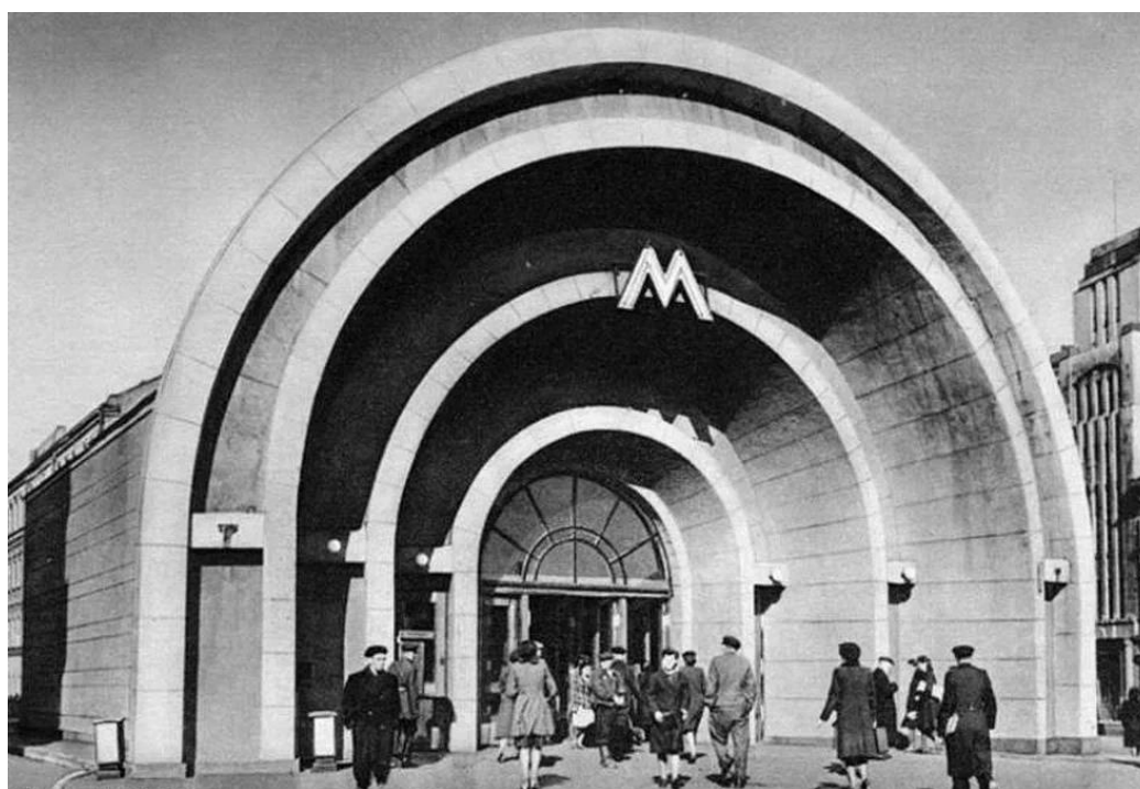
Рис. 6. Портал южного вестибюля станции метро «Красные ворота»
